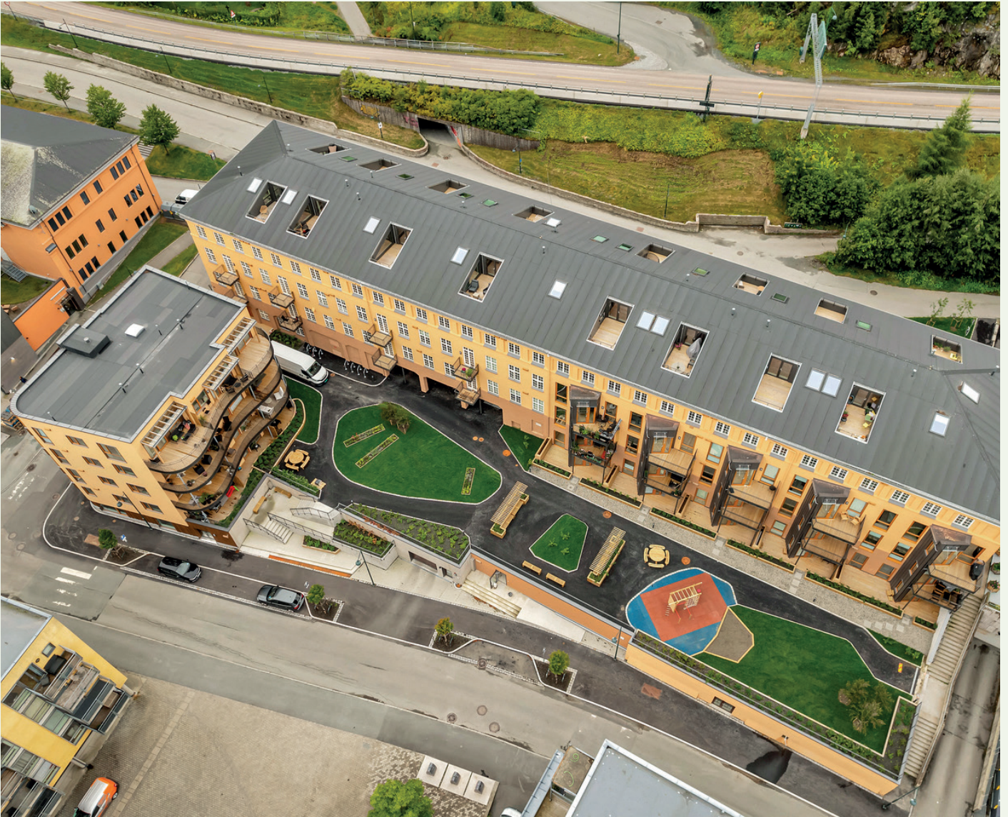
Nordfasaden av Mellomila 79 med nybygget Mellomila 81 foran den gamle fabrikkbygningen.
