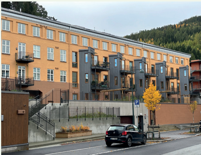
Da tilbygget ble revet oppsto store hull da innervegg ble yttervegg.
